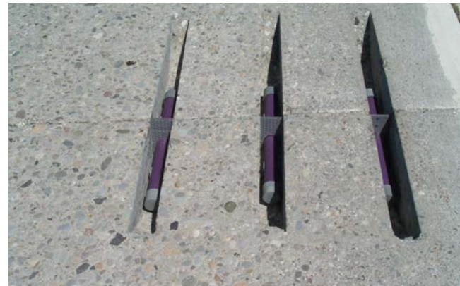
Dowel Bar Retrofit
