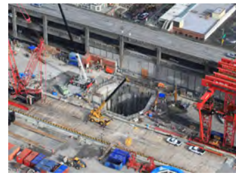
Cảnh hố tiếp cận vào đường hầm nhìn từ trên cao.
