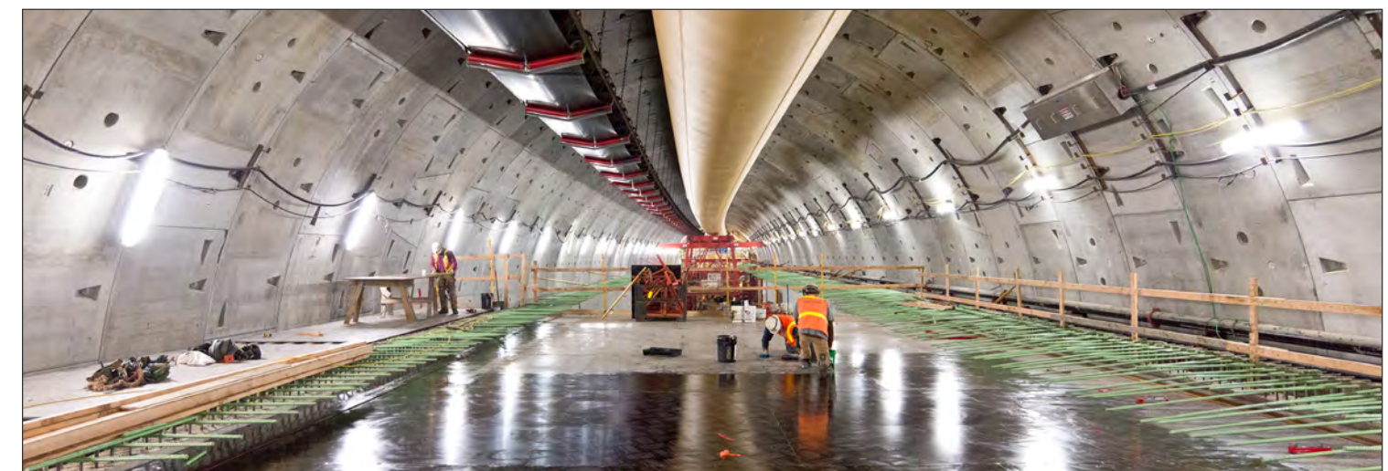
Đội ngũ công nhân đang xây dựng phần lòng đường về phía nam sau này của đường hầm xa lộ tiểu bang 99.
