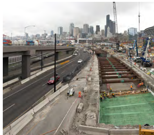
Đội công nhân đang xây dựng làn đường hướng ra phía bắc sau này ở đầu vào đường hầm xa lộ tiểu bang 99 gần sân vận động của Seattle. Phần đường hầm này sẽ dài 1,500 feet, kết nối bề mặt với phần đường hầm được khoan.
