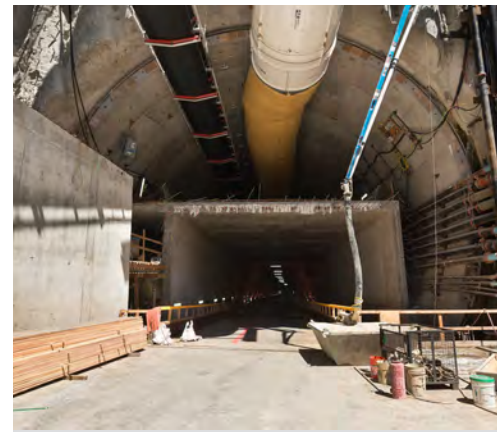
La carretera del interior del túnel va tomando forma en el futuro portal sur.
