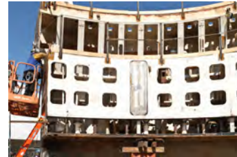
Un soldador reacondiciona la capa protectora exterior de la máquina de excavación.
