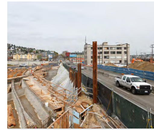
Cuadrillas construyen la conexión entre el túnel y la calle Aurora Avenue North, así como las nuevas rampas de entrada y salida en Republican Street.
