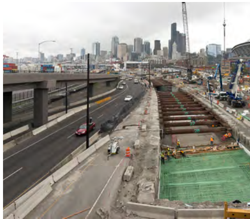
Cuadrillas construyen los futuros carriles con dirección hacia el norte en la entrada del túnel de la carretera SR 99 cerca de los estadios de Seattle. Esta sección del túnel tendrá 1,500 pies de largo y conectará la calle superficial con la sección subterránea del túnel.
