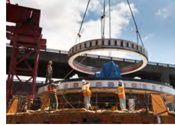
Cuadrillas instalan parte del sistema de sellado recientemente rediseñado para proteger el nuevo cojinete principal de la máquina.
