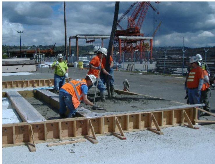
Laborers pour pre-casting beds for pontoons ZC and ZD, April 18, 2007.
