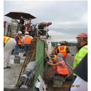
Barrier Pour at Wall 2125.
