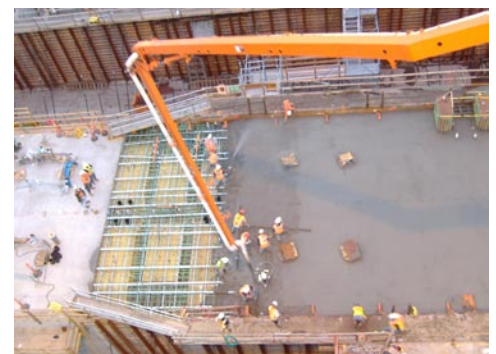
Crews pour concrete for the last top deck pour on pontoon PA, August 8, 2006.
